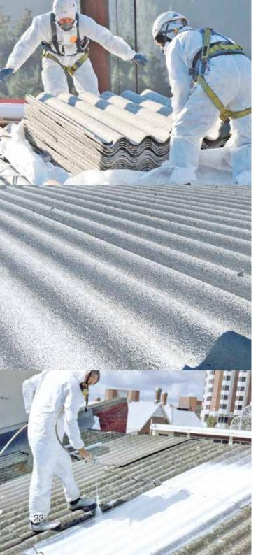
Ventajas del encapsulado y erradicación del fibrocemento con amianto en cubiertas.
